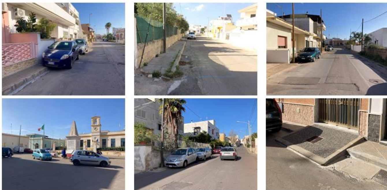
Figura 4-5: Sopraluogo ottobre 2022, stato di manutenzione delle strade
