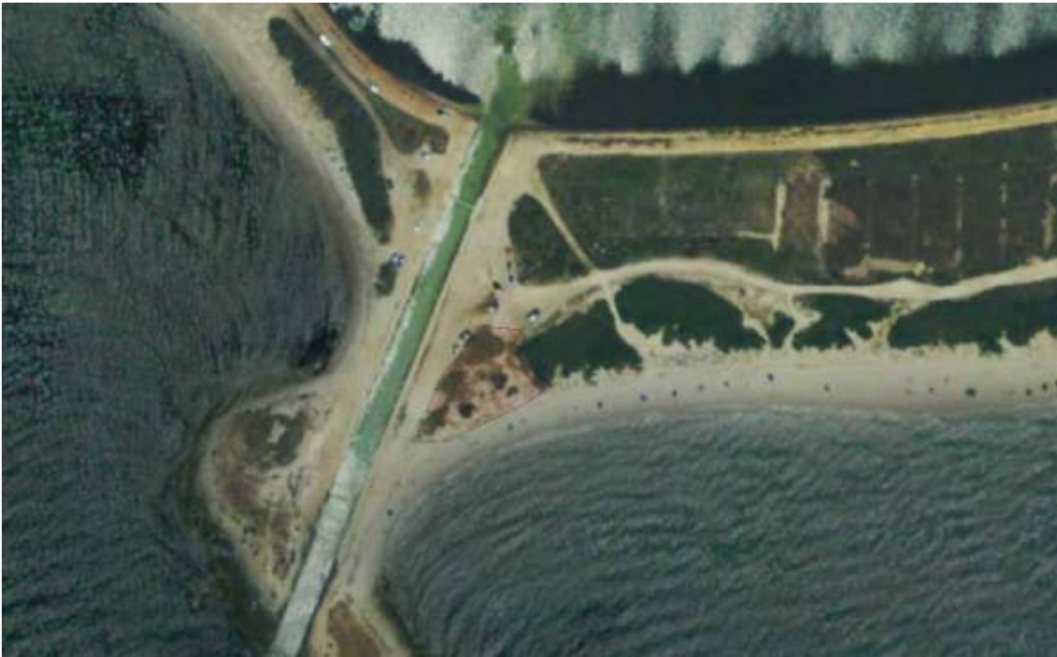
Figura 9: Ortofoto 2013. Zona Lido Marini. In evidenza l'area del cordone dunale oggetto dell'intervento di ricostituzione
