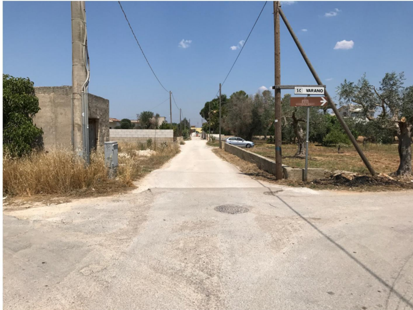
foto reale 1: viabilità rurale esistente
