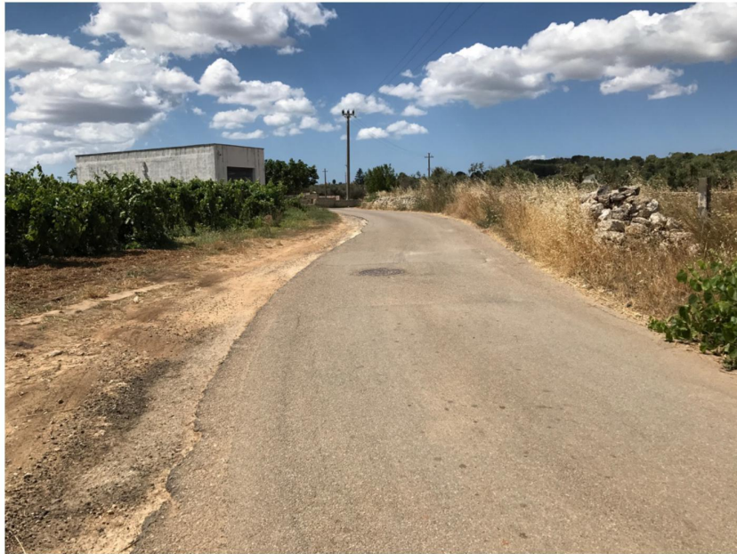
foto reale 6: viabilità rurale esistente
