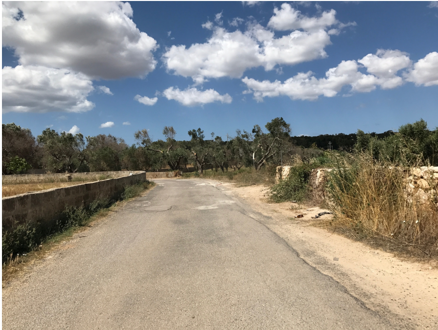
foto reale 7: viabilità rurale esistente
