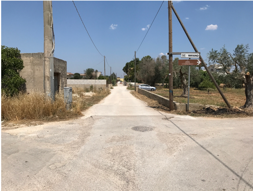
foto reale 1: viabilità rurale esistente
