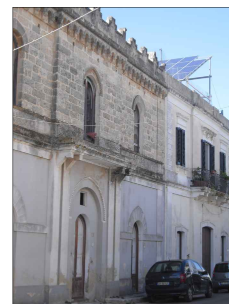
Colorazione secondo criteri della proprietà. Mancanza di intonaco al piano primo. Struttura metallica con pannelli fotovoltaici.
