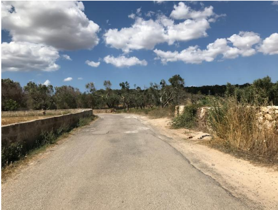
foto reale 7: viabilità rurale esistente
