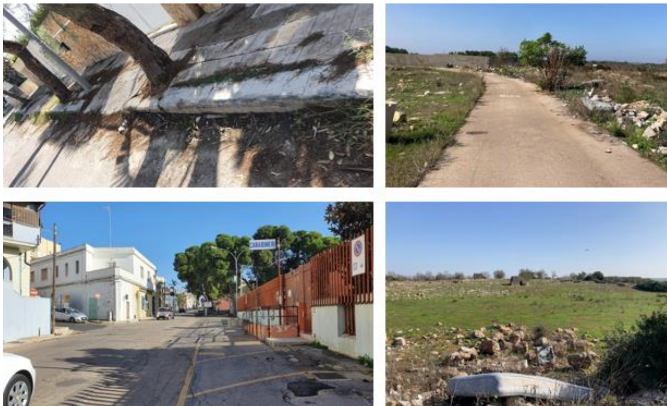
Figura 2-1: Sopraluogo ottobre 2022, stato di manutenzione delle strade
