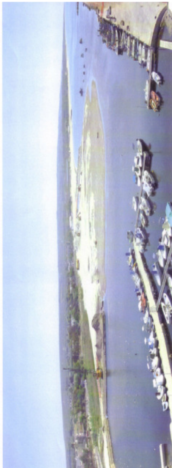
Figura 3. Stato del porto nel corso dei lavori di cui al finanziamento regionale 2003. Si osserva che l'interrimento del porto quasi lambisce e occlude l'imboccatura dello stesso, formando ivi una barra.
