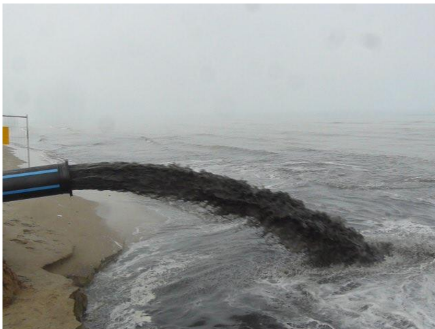
Figura 5.3.3: Vista della fase sversamento dei sedimenti dal sabbiodotto alla spiaggia da ripascere.
