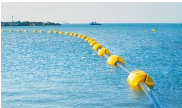
Figura 4.2.4: Vista della tubazione di collegamento draga- sabbiodotto mantenuta in emersione mediante galleggianti in HDPE.
