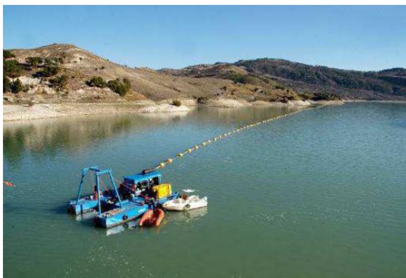
Figura 5.3.1: Vista della draga con tubazione galleggiante di collegamento al sabbiodotto fisso.
