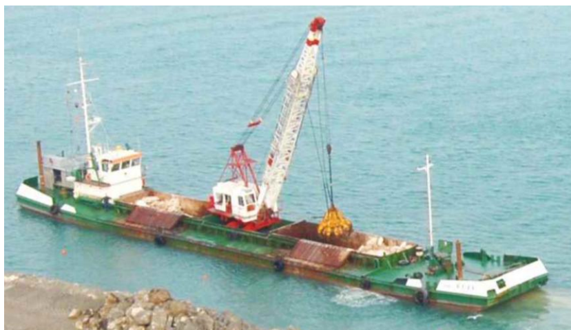
Figura 4.2.2: Esempio della fase di carico dei sedimenti dragati sul mezzo marittimo (motopontone).
