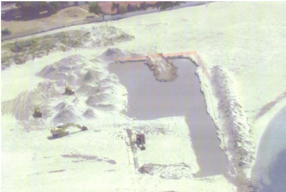
Figura 6. Stato dei lavori di dragaggio per l'alloggiamento del pennello "da terra" (anno 2003)
