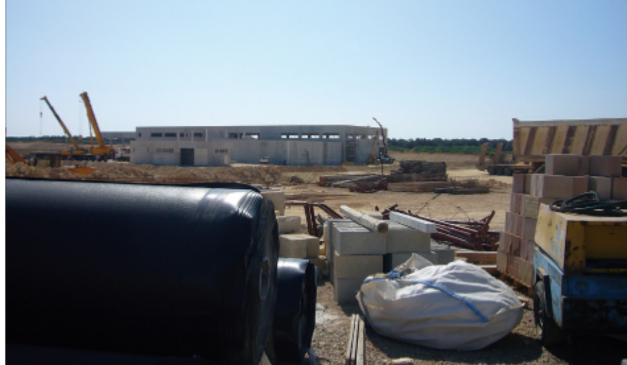
Il nuovo impianto in costruzione
