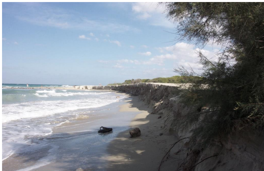
Figura 25 Erosione a sud dei pennelli ed interessamento dell'apparato radicale.
