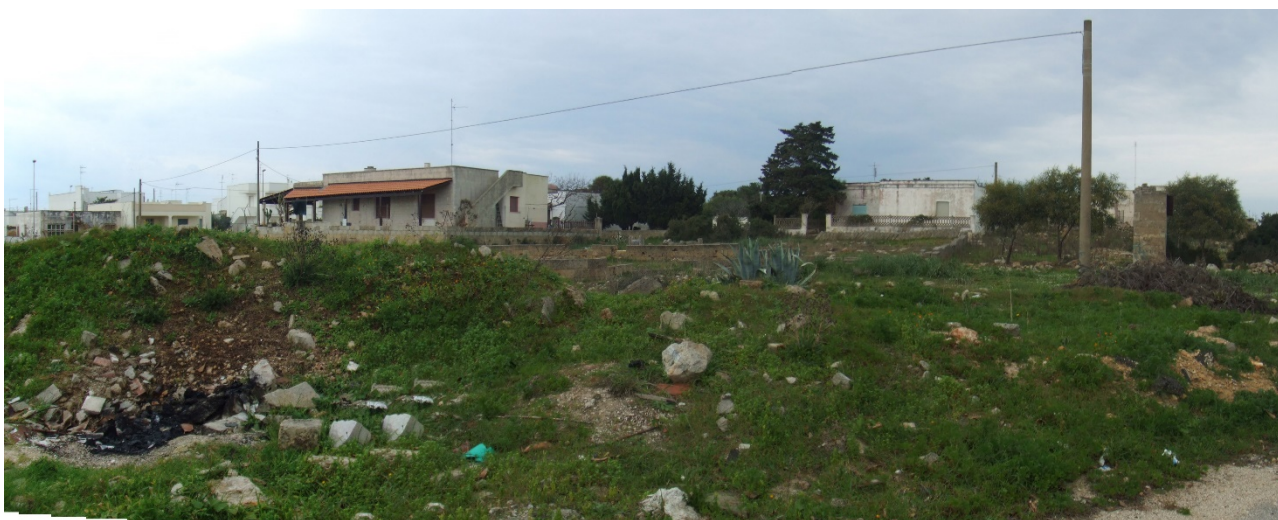
Area centrale del comparto con evidenziato il livello di degrado
